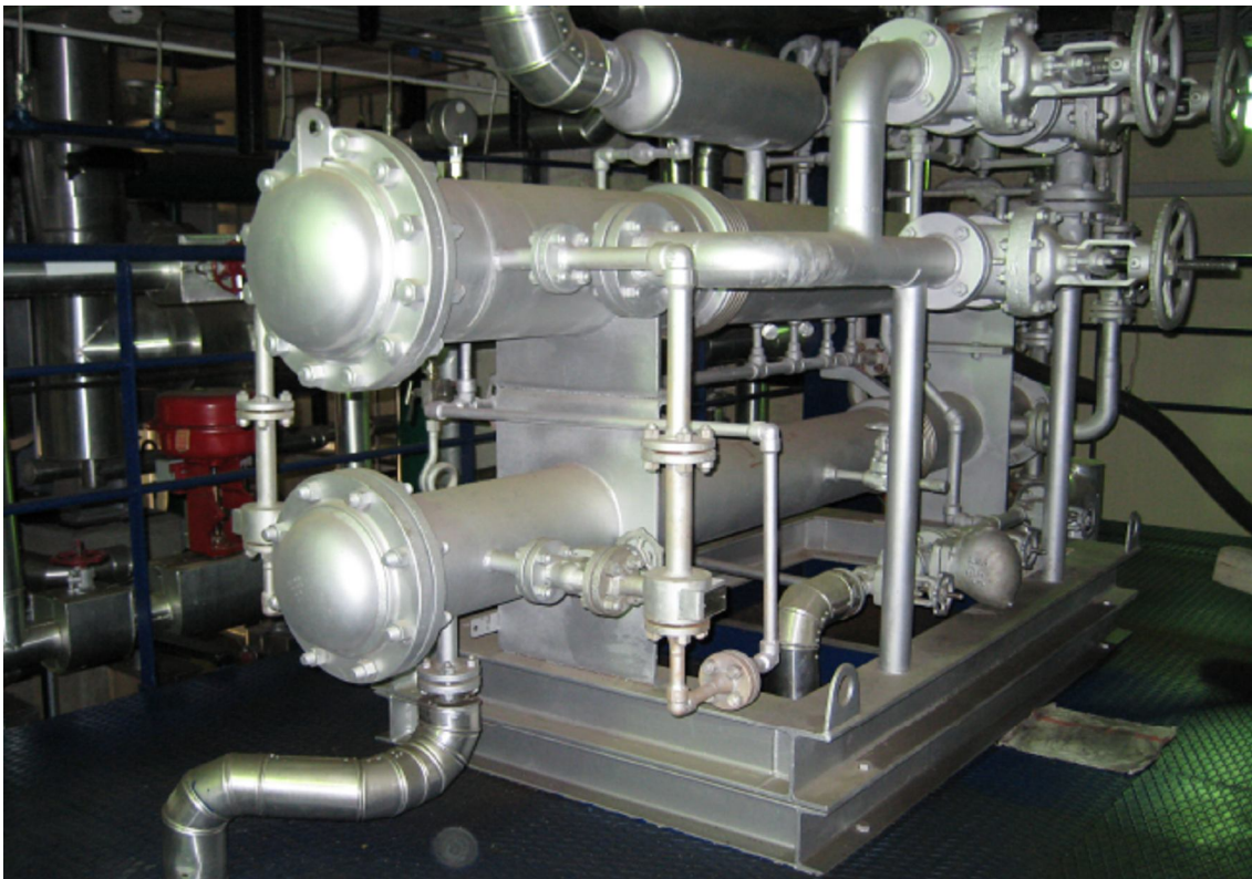
Slika 3.6. Ejektorski sustav
