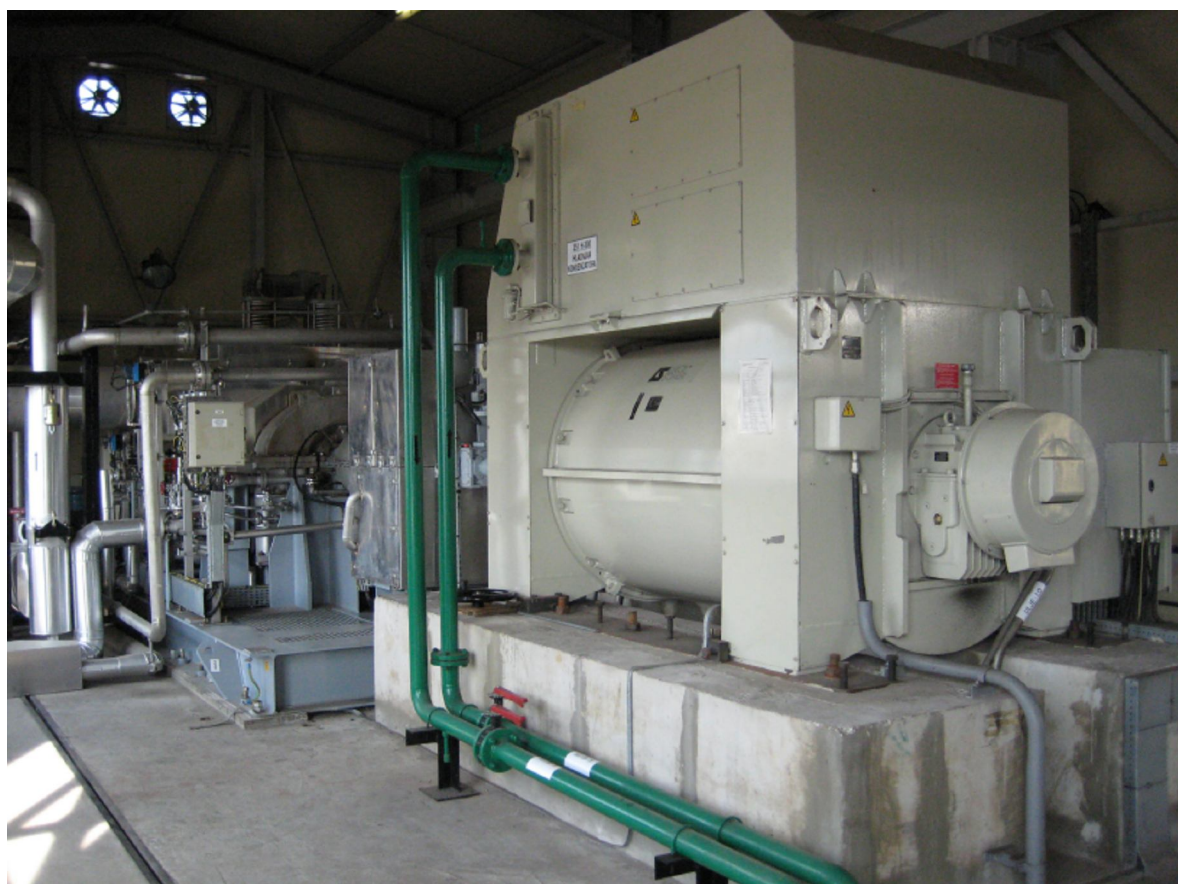
Slika 3.3. Turbogeneratorski sklop
