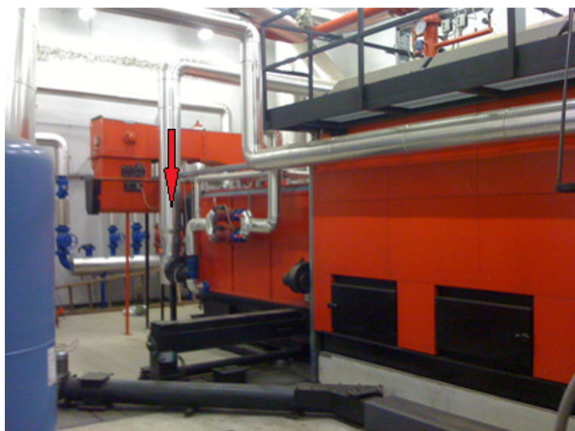
Slika 30 Povrat dimnih plinova u zonu izgaranja - recirkulacija
